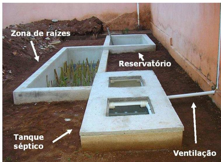
Figura 1: Vista geral do sistema residencial de tratamento de esgoto avaliado, em fase final de construção, ainda sem as tampas do tanque séptico e do reservatório. Goiânia, GO. 2008.
