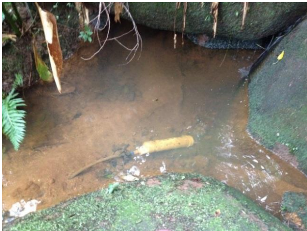
Figura 3 – Ponto de captação de água com utilização de um tubo de PVC.
