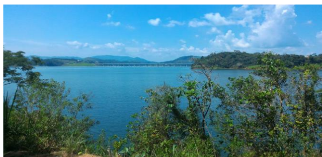
Figura 1. Reservatório do Rio Atibainha (acervo da pesquisadora).
