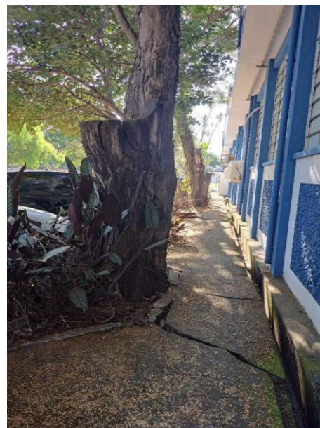
Figura 7. Pavimentação danificada por afloramento de raízes, além de estar inserida a menos de um metro da calçada. Indivíduo do Bloco E.
