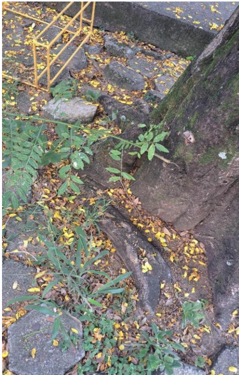
Figura 8. Passagem danificada por afloramento de raízes. Indivíduo do Bloco A.
