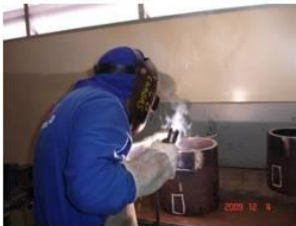
Figura 5. Soldador realizando amanteigamento na boca do tubo.
