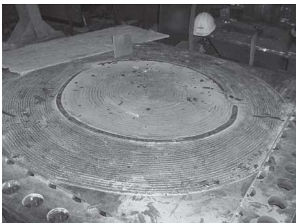
Figura 3 – Início do revestimento por soldagem
