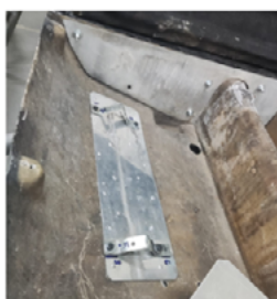
Reforço do assoalho
