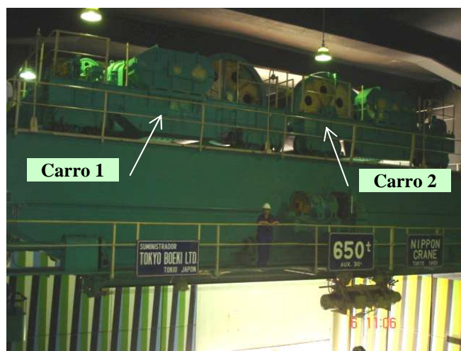
Figura 7. Vista geral da ponte rolante a ser reformada.
