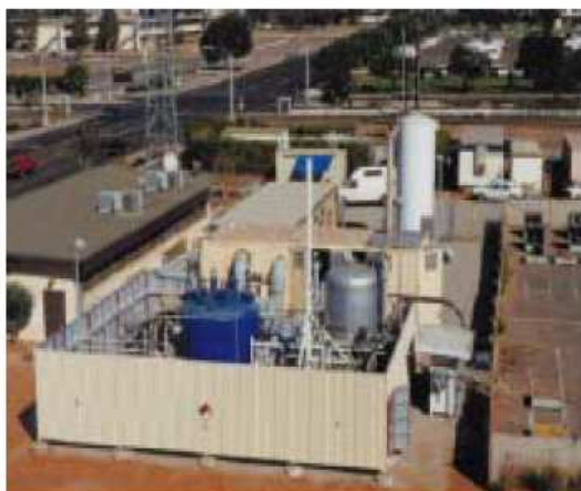
Figura 9. Generación descentralizada 250kW MCFC – Miramare Marine Corps Air Station San Diego- California, USA
