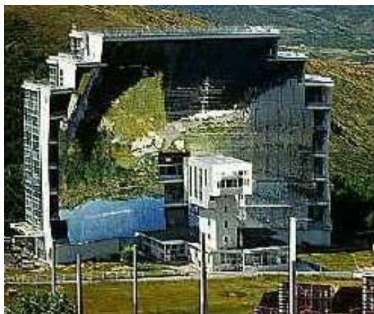
Figura 3 - Forno solar. Fonte: site portal São Francisco (2010)
