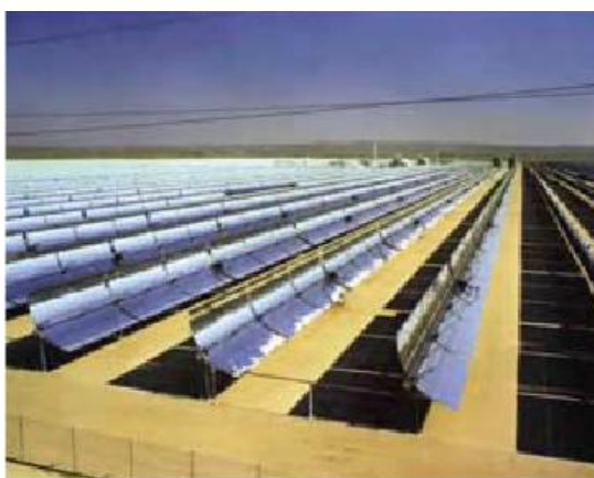
Figura 4. Sistema térmico de geração solar de energia elétrica (Califórnia – EUA). Fonte: National Renewable Energy Laboratory (EUA) – NREL (2000).
